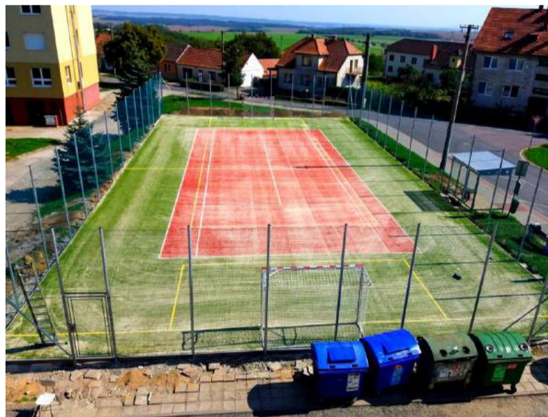
Hřiště u školy - kurt těsně před dokončením
