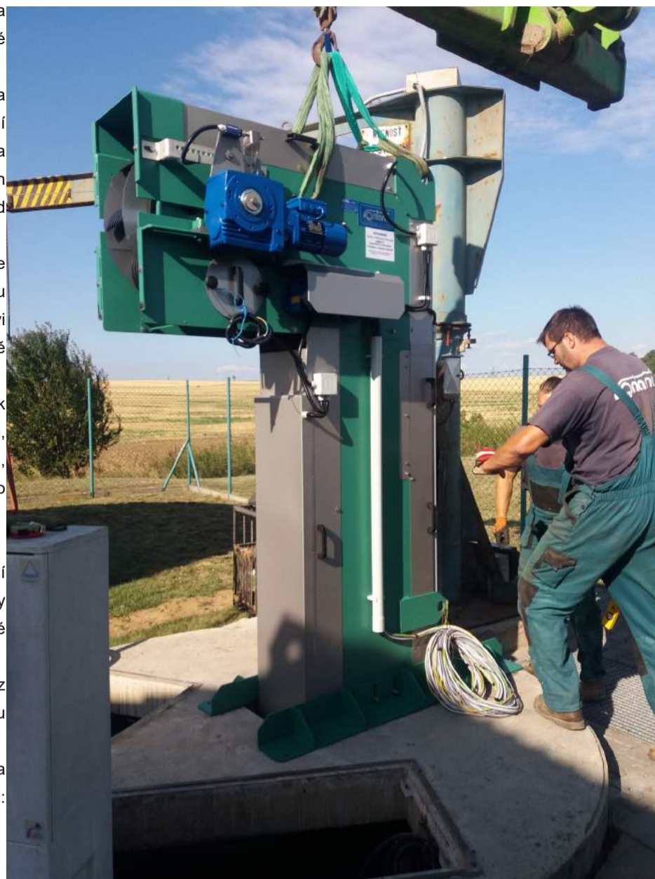
15. 8. 2018 Instalace nových česlí na čističku odpadních vod
